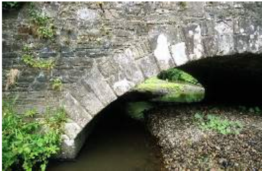
LAIAR-016-003_03 FWH 14/06/2007 Voussoirs detail (middle arch).
